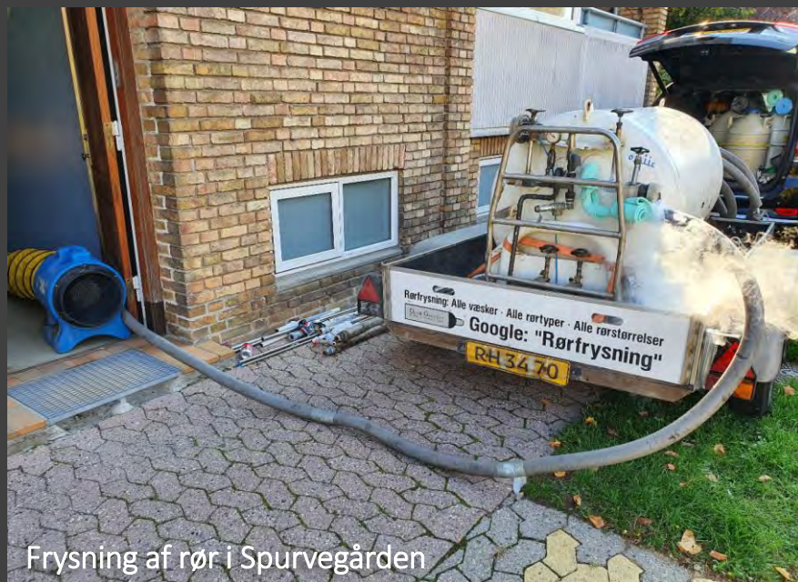
Renovering af muffe – opdaget ved hjælp af opgraderet meldetrådssystem
