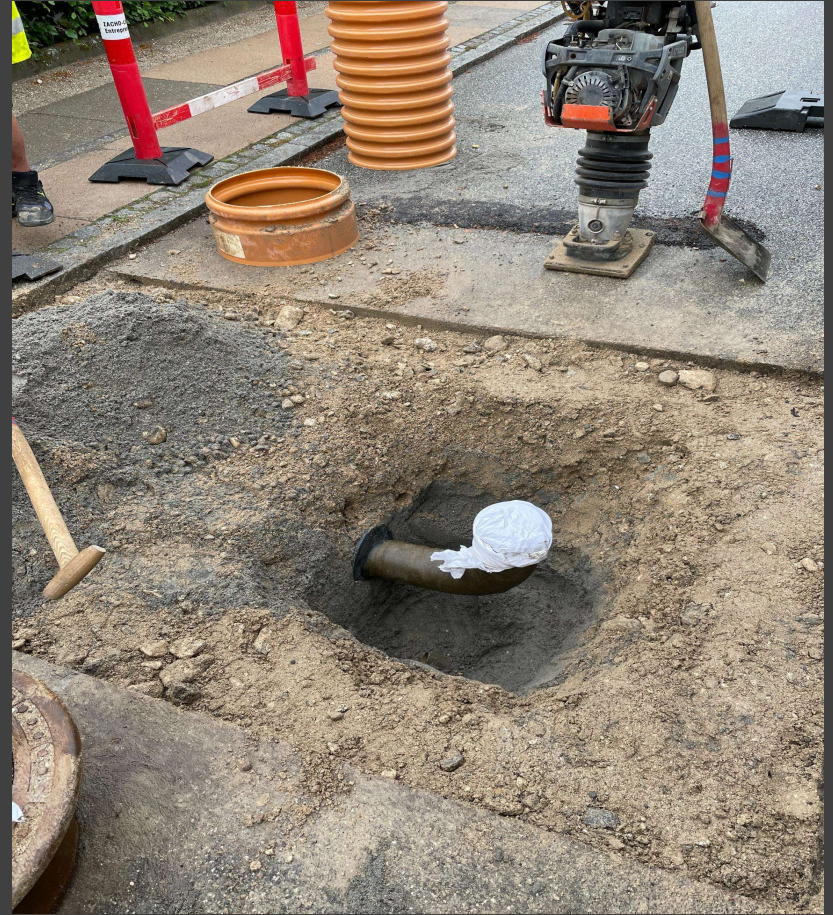
Renovering af påfyldningspladsen for olie
