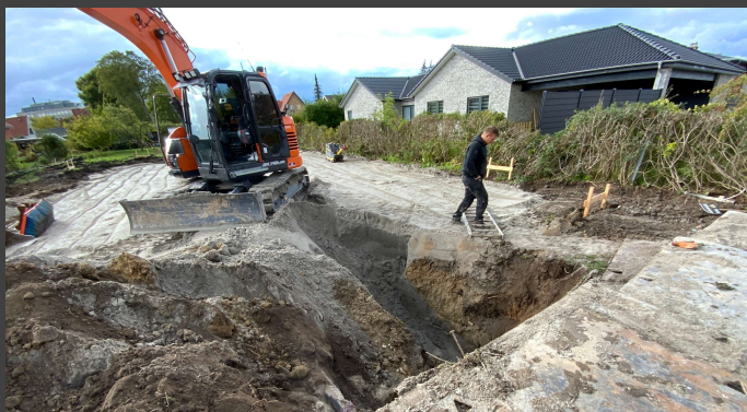
Overgravning af stikledning i Risbjerg
