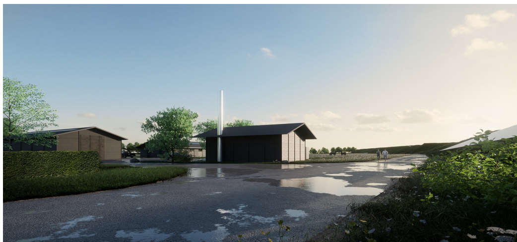
Varmeproduktionsanlæg ved Ridecenteret
