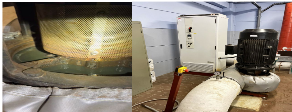
Arbejde med pumper og akseltætning på centralen
